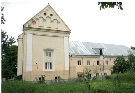
Klasztor oo. Reformatorów i Kościół Wniebowzięcia NMP Sądowa Wisznia, 2019
